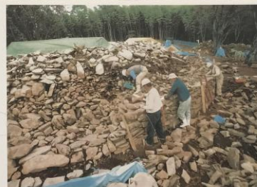
後円部の復元工事風景 (H13)
