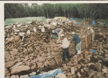
後円部の築工事現場 (H13)
